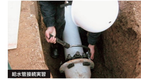
給水管接続実習
